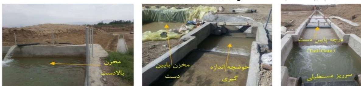
شکل ۳- الف: سرریز مستطیلی و دریاچه تنظیمی ( tailgate ) ب- حوضچه اندازه‌گیری و استخر پایین‌دست ج: مخزن بالادست.
