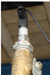
شکل ۳ - سنسور فشار. شکل ۴ - نصب سنسور فشار.
