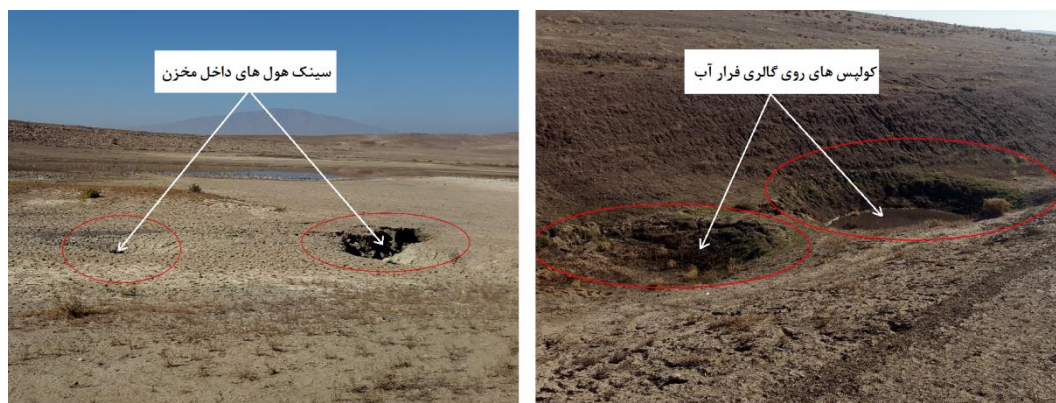
شکل ۱۰- تصویر فروچاله های داخل مخزن سد آرباتان و ریزش های عمقی روی گالری
