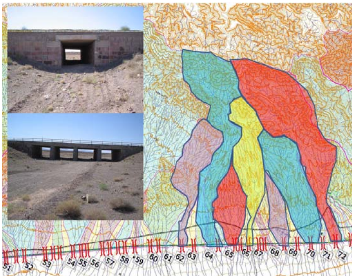
شکل ۸- تخلیه غیرمجاز نخاله در سرشاخه روستای چهار چشمه. شکل ۹- حوزه بندی جهت طراحی کالورت های مسیرهای برون‌شهری.
