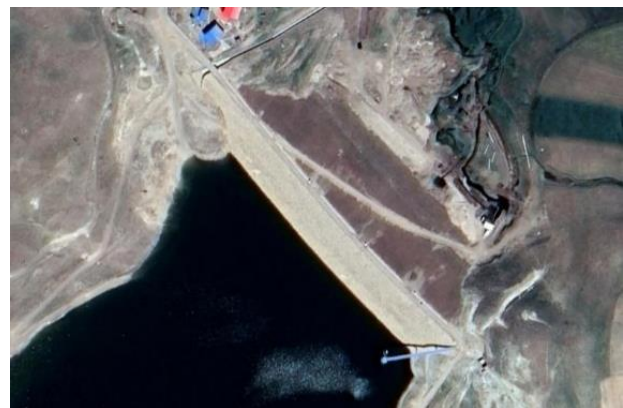
شکل ۲- نمای کلی سد خاکی بفرآورد.
