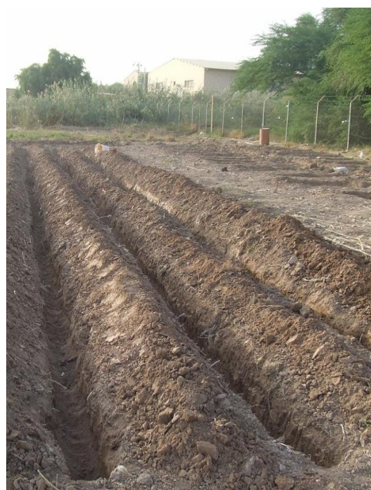
شکل ۲- طرح کلی سیستم آبیاری چگالشی (راست) و ترانشه‌های حفر شده به طول ۲۵ متر و عمق ۴۰ سانتیمتر (چپ).
