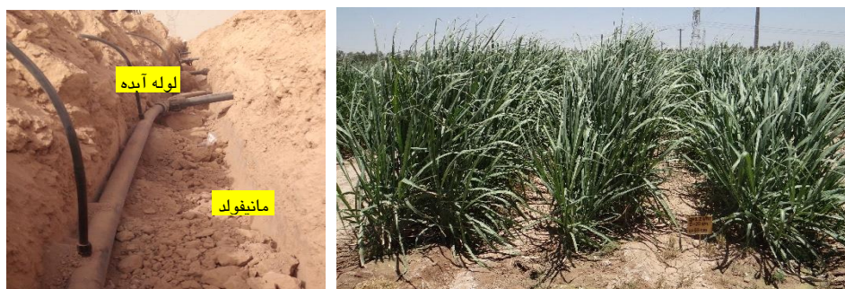
شکل ۱- نحوه اتصال لوله آبدۀ به مانیفولد و گیاه نیشکر در یکی از تیمارها.
